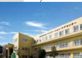
介護老人保健施設 泉崎南東北リハビリテーション・ケアセンター (福島県泉崎町)
